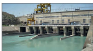
Водозаборные сооружения Республика Калмыкия
